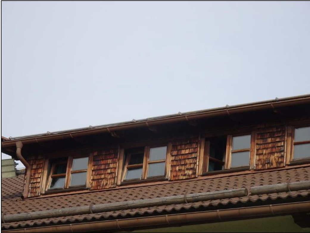
Abb. 14: Nordseite mit Schindeln.
