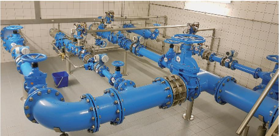
*Rohre, Pumpen, Messinstrumente, Schieber und vieles mehr bestimmen die Technik der Wasserversorgung, die ständig überprüft und gewartet werden muss*
