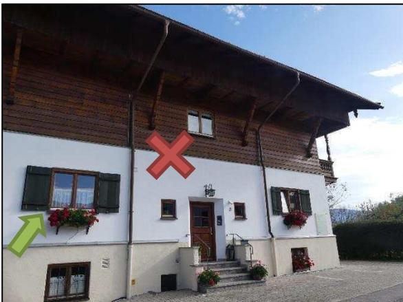
Bild 05: Die umlaufende Holzverkleidung sowie div. Balkone schließen dicht mit der Fassade ab, so dass hier keine Spalten vorhanden sind (rote Kreuze)
